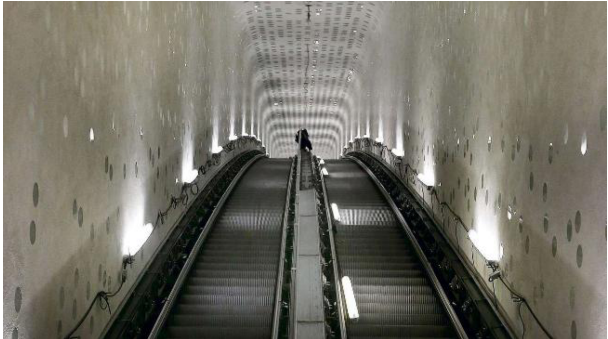
Abbildung 1 Gewölbte Fahrtreppe im Eingang zur Elbphilharmonie, Quelle: ( www.bild.de aufgerufen am 04.03.2015)
