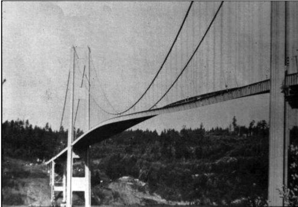
Abbildung 13.1: Die 1940 durch eine Resonanzkatastrophe eingestürzte Tacoma-Narrows-Brigde. Quelle: [32]
