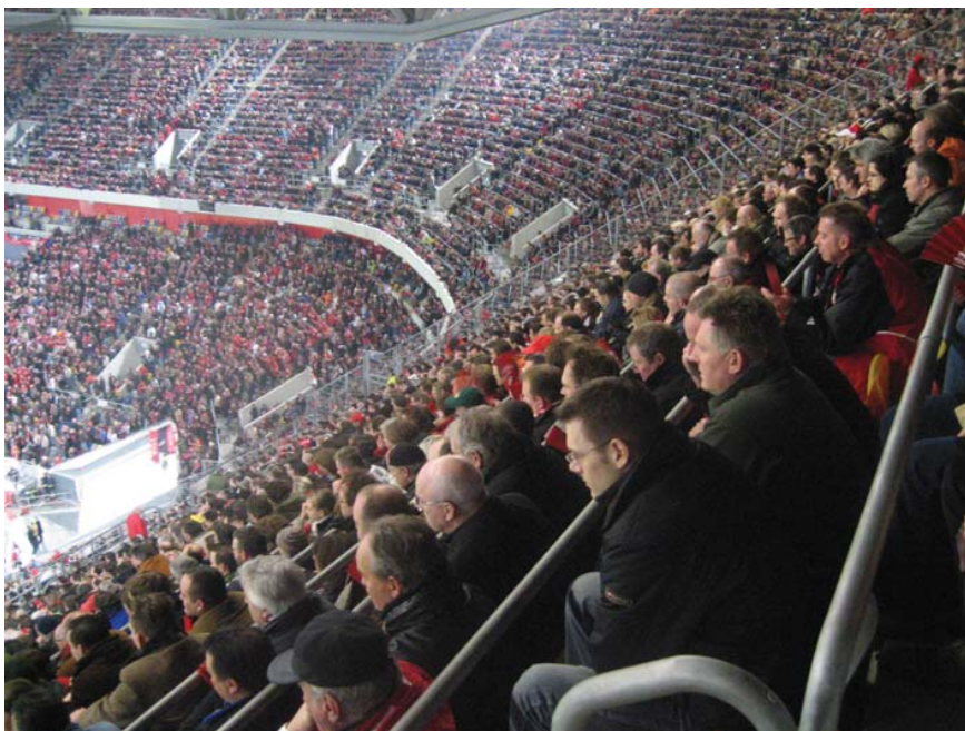
Abbildung 4.1: Foto der ESPRIT arena in Düsseldorf
